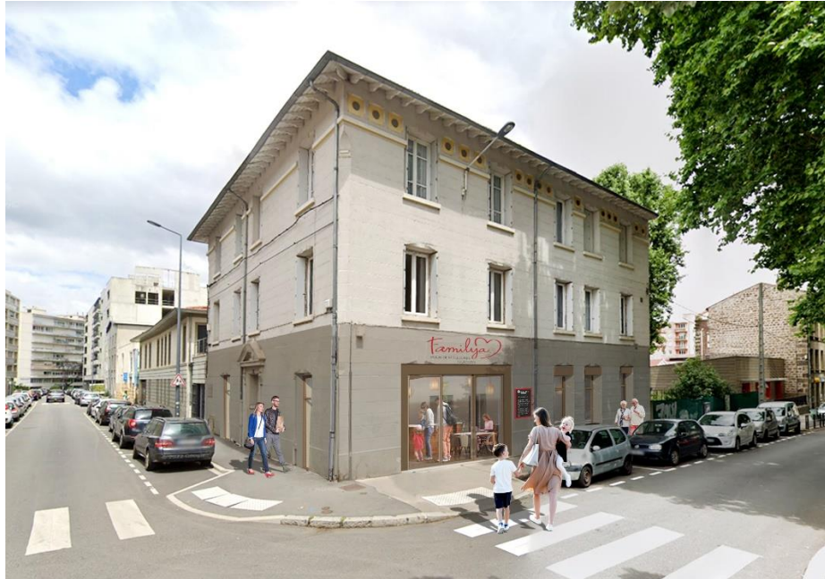
Vue de façade du projet 12 square Girodet 42 000 Saint-Etienne
